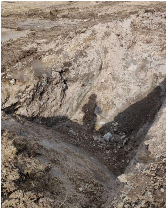
Kuva 12. Koekuoppa KK3. Kuvaussuunta pohjoiseen.
