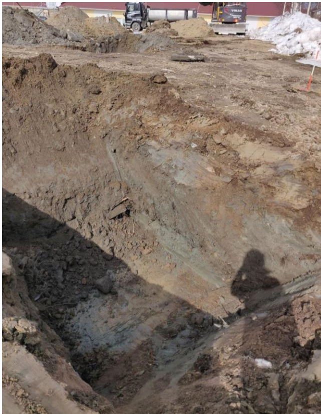
Kuva 22. Koekuoppa KK5. Kuvaussuunta pohjoiseen.
