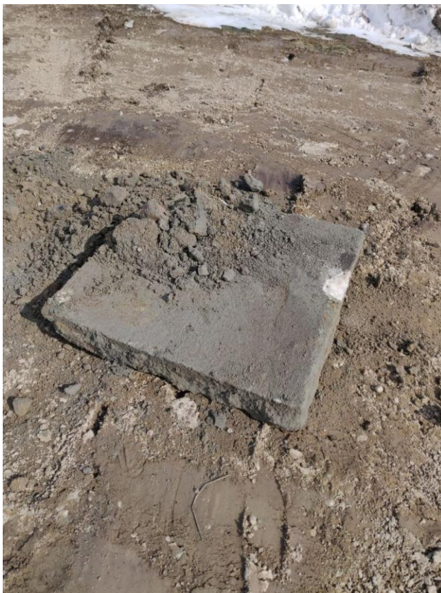
Kuva 20. Koekuopasta KK4 havaittu betonilaatta.
