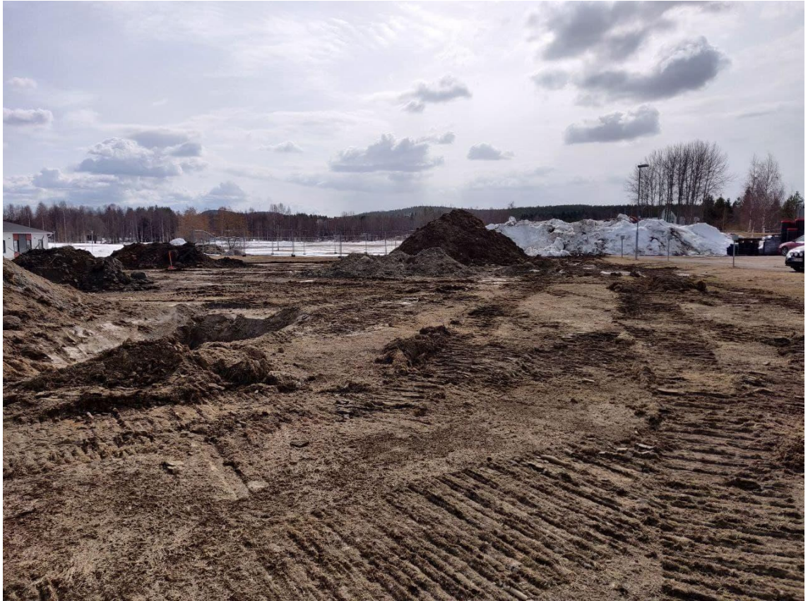
Kuva 1. Yleiskuva kohteesta. Kuvaussuunta etelään.
