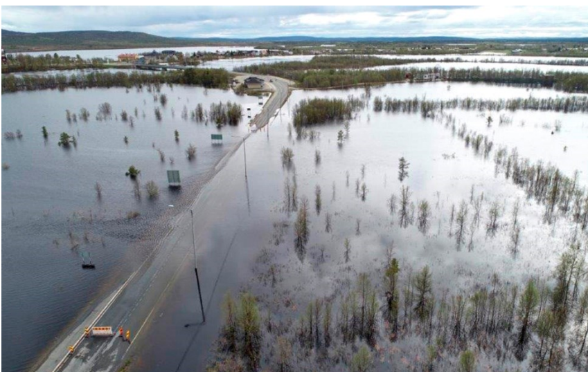
Kuva 3. Tulva on noussut tielle kevään 2020 tulvassa Karesuvannossa (kuva Lapin ELY-keskus)
