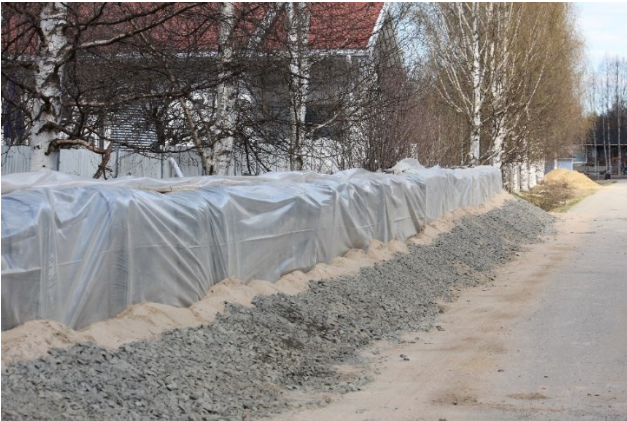
Kuva 6. Tilapäinen tulvaseinä Rovaniemen Saarenkylän terveysaseman suojaamiseksi kevään 2020 tulvassa (kuva: Lapin ELY-keskus)
