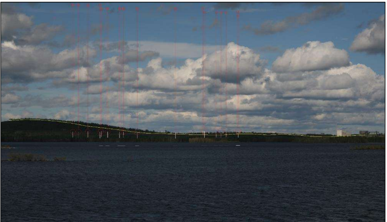
Kuva 35. Kuvauspiste 7, Kemijärvi, Rautatiesilta (itäpääty), näkymä koilliseen. Etäisyys lähimpiin voimaloihin n. 22,8 km. 50 mm polttoväli. Osa voimaloista näkyy taustamaisemassa puuston latvuston yläpuolella. Pohjoisosan voimalat jäävät kokonaan katveeseen vaaranrinteen taakse. Maiseman muutos vähäinen.
