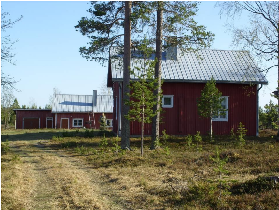
Kuva 24 Tilan rakennukset on tarkoitus säilyttää ja kunnostaa. Ne jäävät kaavan ulkopuolelle, mutta niitä voidaan hyödyntää esim. rakentamisen aikana ja alueen opastuksessa
